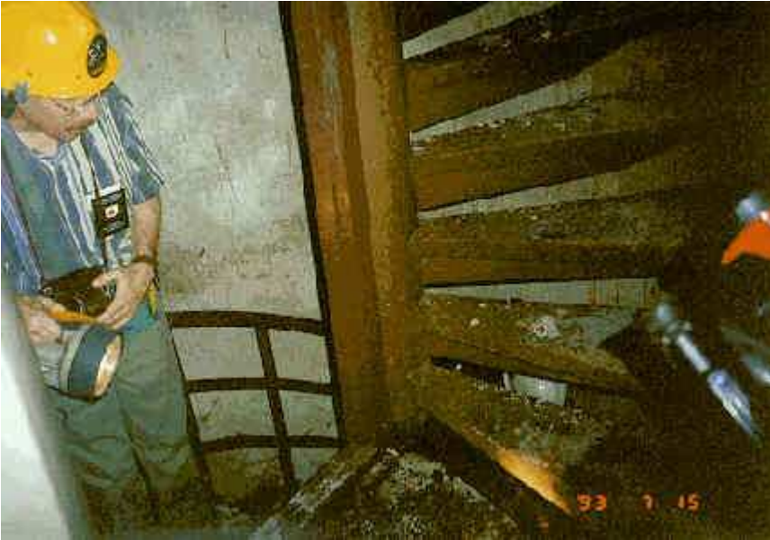
รูปที่ 11 ความเสียหายจากการใช้บันไดเวียนเป็นบันไดหนีไฟ
