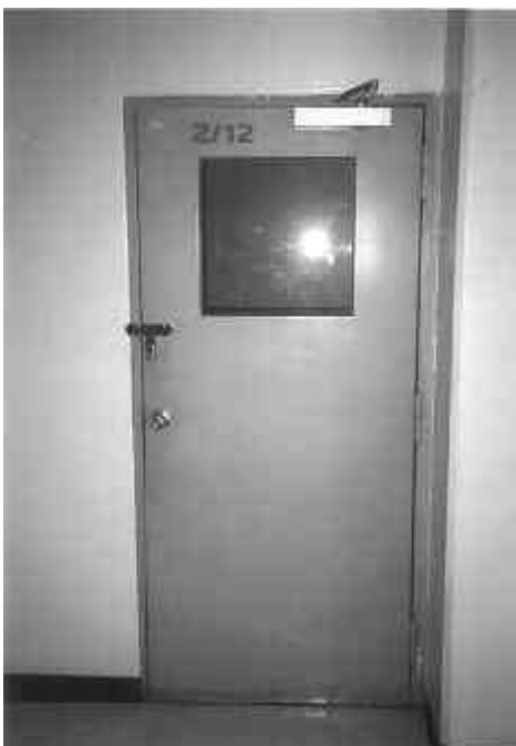
รูปที่ 23 ปัญหาของการใช้ลูกบิดที่ประตูหนีไฟ และการใส่กุญแจล็อก
