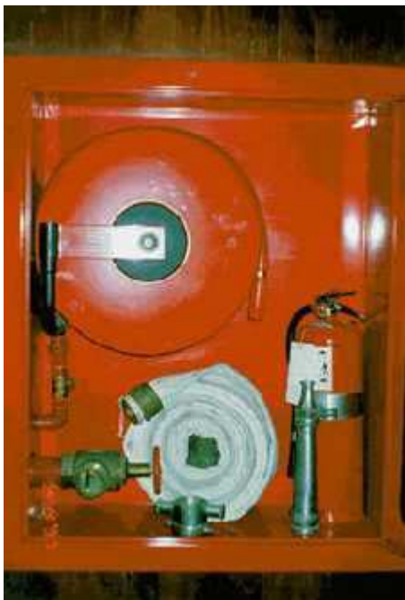
รูปที่ 2 ตัวอย่างตู้เก็บสายฉีดน้ำดับเพลิง พร้อมอุปกรณ์ สำหรับติดตั้งภายในอาคาร
