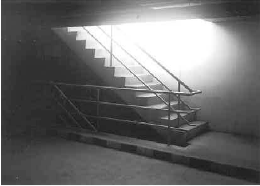
รูปที่ 9 บันไดหนีไฟที่ต้องวิ่งวนออกมานอกบันไดทุก
