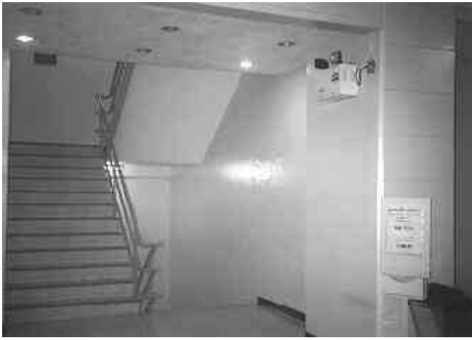
รูปที่ 3 บันไดภายในอาคารที่ไม่มีประตูปิด
