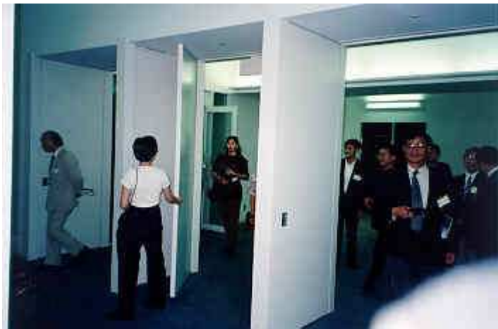
รูปที่ 22 ประตูกันไฟที่ปิดระหว่างทางเชื่อมระหว่างปีกของอาคาร
