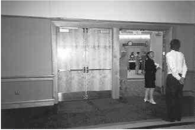
รูปที่ 21 ประตูของห้องจัดงานตามมาตรฐานสากลทุกห้องจะใช้ Push Bar
