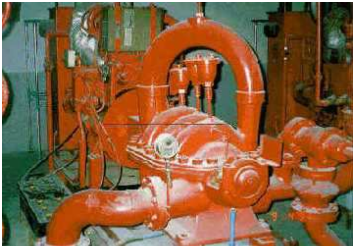
ตัวอย่างเครื่องสูบน้ำดับเพลิง ชนิดขับเคลื่อนด้วยเครื่องยนต์
