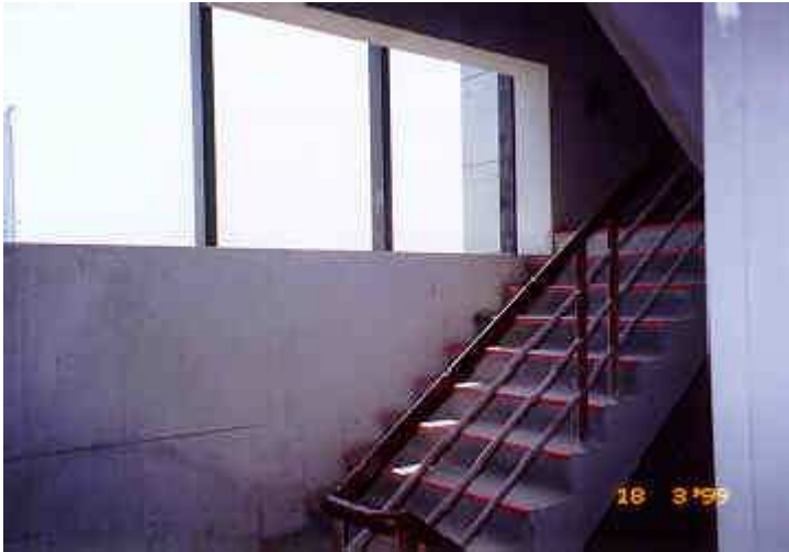
รูปที่ 19 ช่องเปิดระบายอากาศที่บันไดหนีไฟกำลังรอใส่เกล็ดดอลูมิเนียมติดตาย
