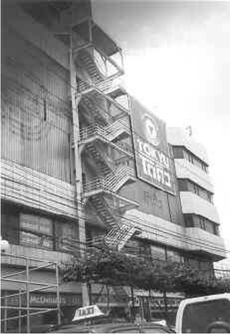
รูปที่ 17 บันไดโล่งนอกอาคาร แต่ผนังอาคารด้านที่ติด บันไดต้องเป็นผนังทนไฟด้วย
