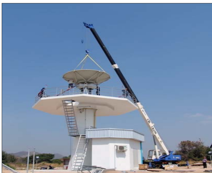
รูปที่ 18 การใช้รถเครนในงานก่อสร้าง
