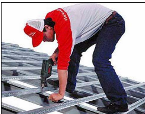
รูปที่ 7 การทำงานของผู้ปฏิบัติงานโดยประมาท ไม่มีการป้องกันภัย
