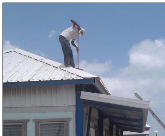
รูปที่ 7 การทำงานของผู้ปฏิบัติงานโดยประมาท ไม่มีการป้องกันภัย
