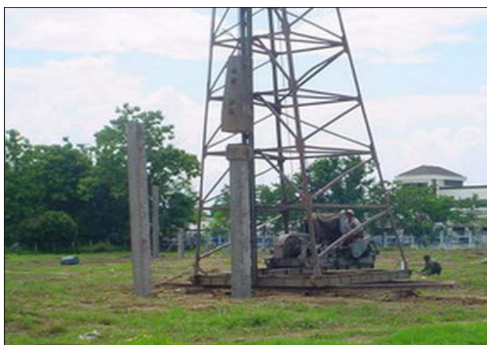
รูปที่ 6 การสิ้นเปลืองจากการตอกเสาเข็ม
