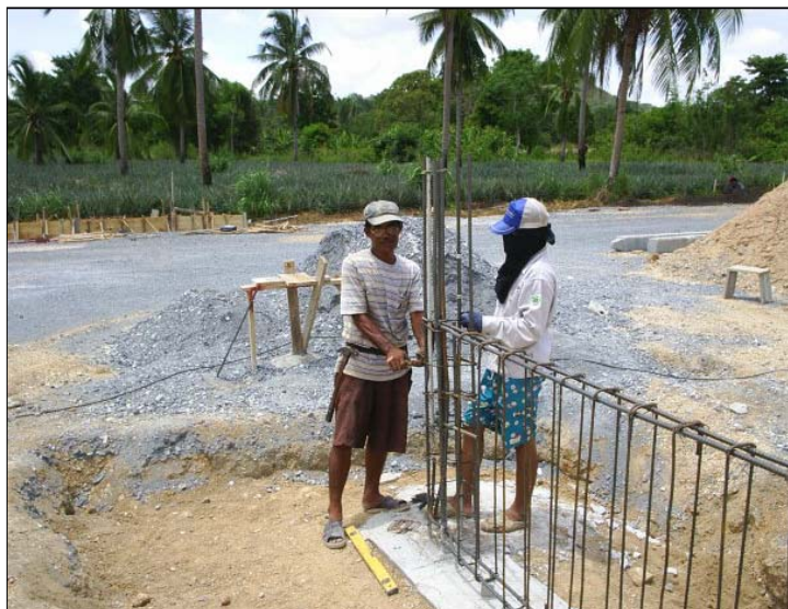
รูปที่ 16 การแต่งกายที่ไม่ถูกระเบียบในการก่อสร้าง
